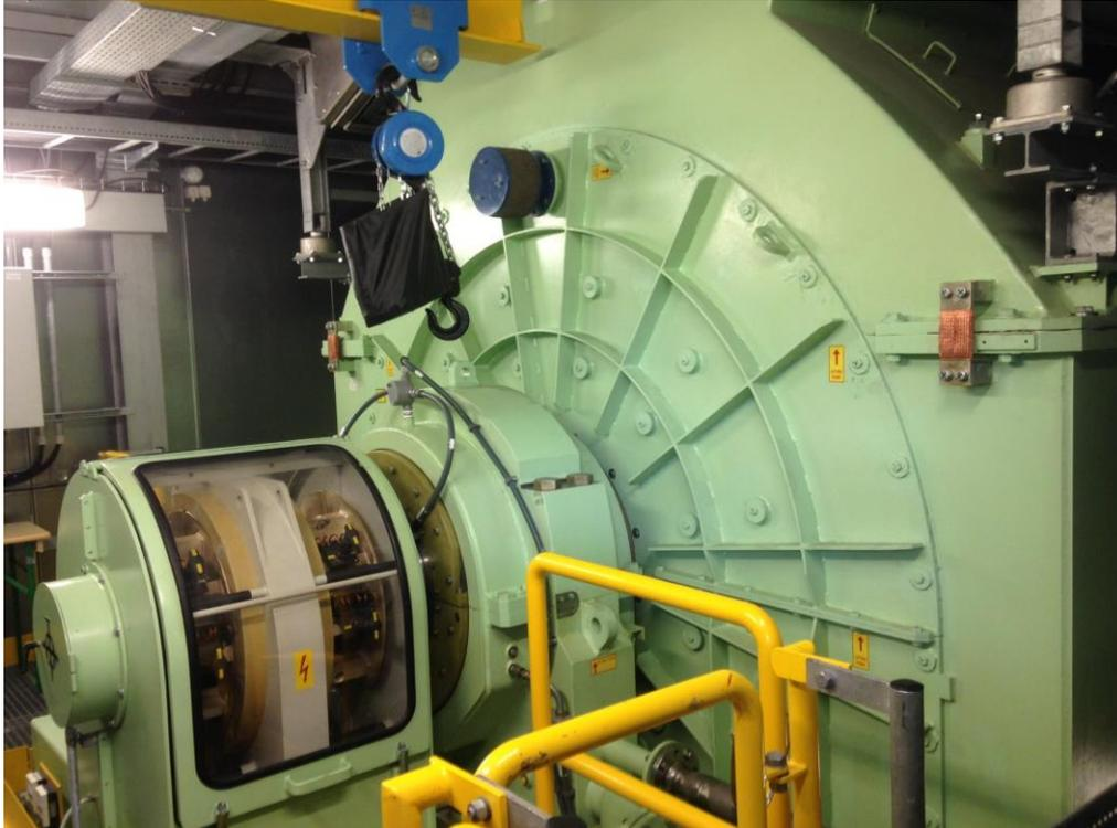
Rotierender Phasenschieber der TenneT in Bergheinfeld (Gewicht Generator: 360 t)
